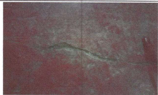
Foto 4: Piso agrietado
