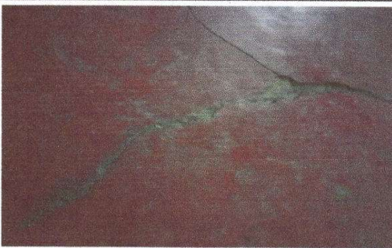
Foto 5: Piso agrietado
